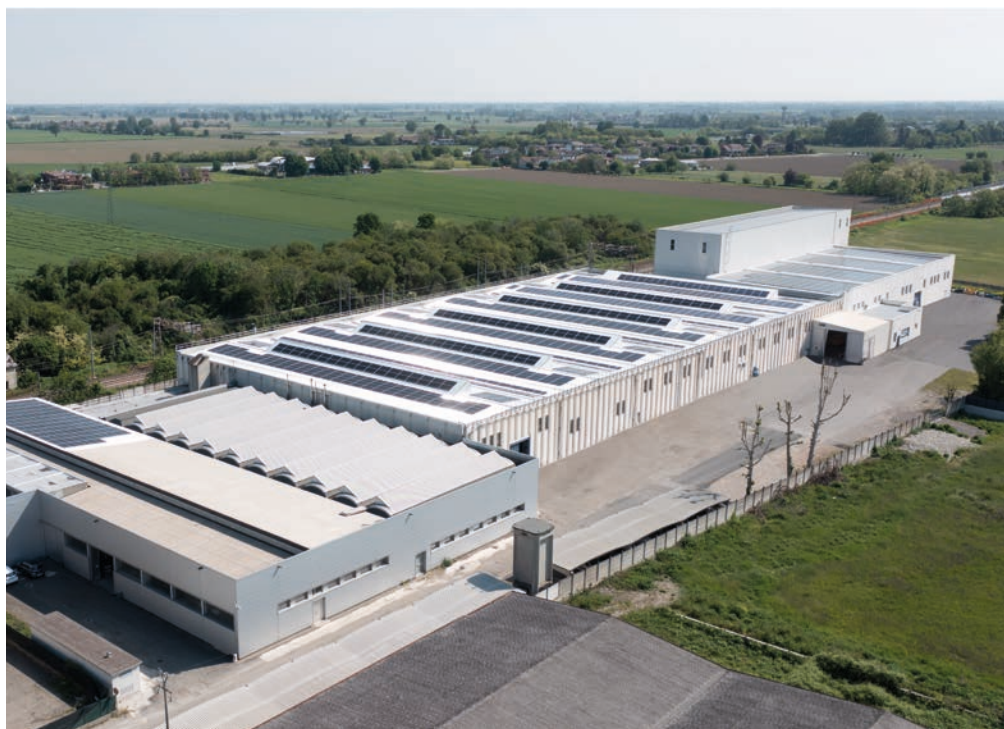
Lo stabilimento Unitec di S. Nicolò a Trebbia-Rottofreno (PC)
